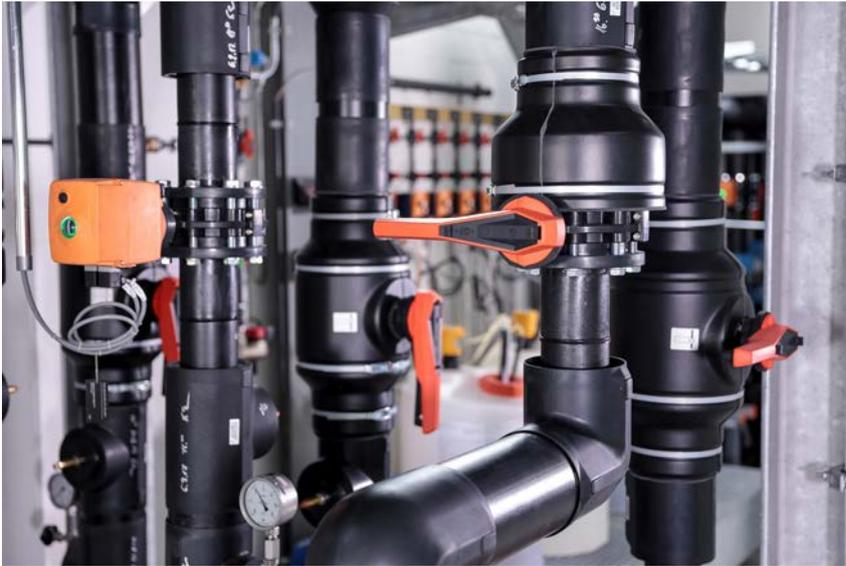
COOL-FIT 4.0 ermöglicht eine zuverlässige und sichere Kühlung von industriellen und gewerblichen Kühlsystemen mit 30% höherer Energieeffizienz.
