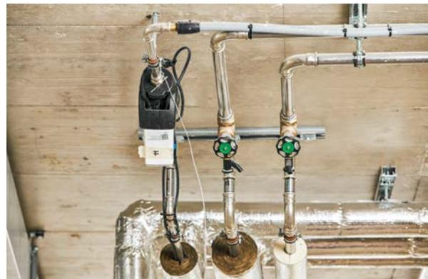
Das Hycleen Automation System sorgt durch Zirkulation mit automatischem Abgleich langfristig für beste hygienische Bedingungen.
