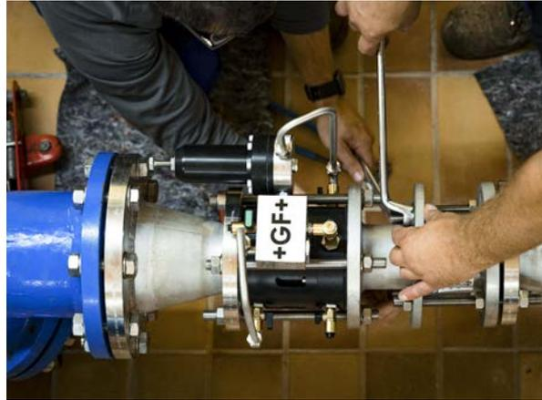
Modernste Technologien wie NeoFlow schützen die Wasserverteilungsnetze vor Überdruck und reduzieren gleichzeitig Leckagen und Rohrbrüche.
