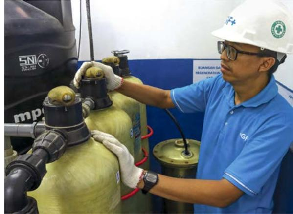
Der Standort Jawa Barat begann, das Wasser aus hydrostatischen Druckprüfungen von Rohrleitungen wiederzuverwenden. Es wird in einem Tank gesammelt, gefiltert und für denselben Zweck rezykliert.
