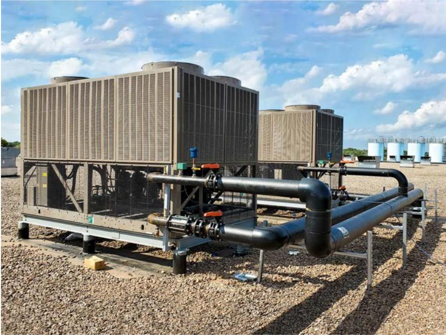
Installation neuer energieeffizienter Kühlanlagen am Standort von GF Piping Systems in Shawnee (USA).
